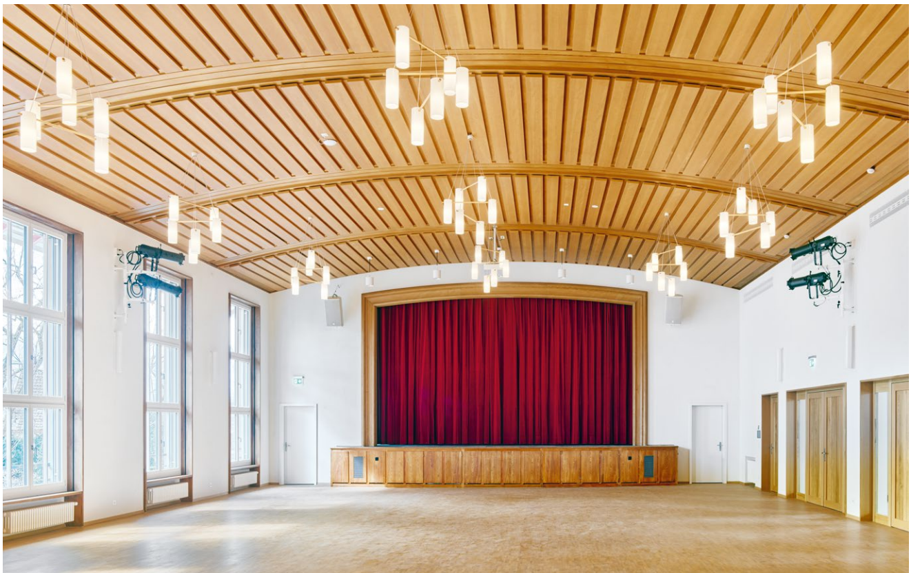
Dank der freigelegten, tonnenförmigen Holzdecke hat der Saal seine alte Grösse und Festlichkeit zurückerhalten.
